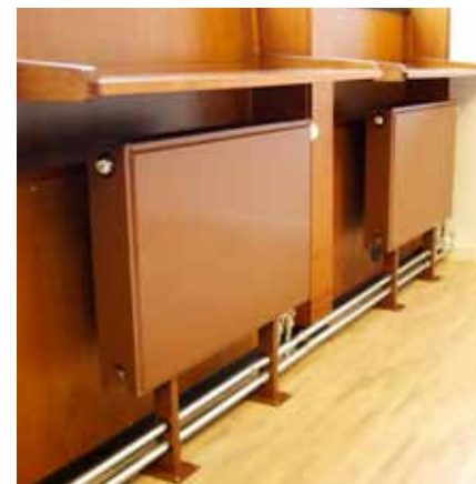
Elektriske panelovner er erstattet med radiatorene med vann fra fjernvarme som energikilde.
