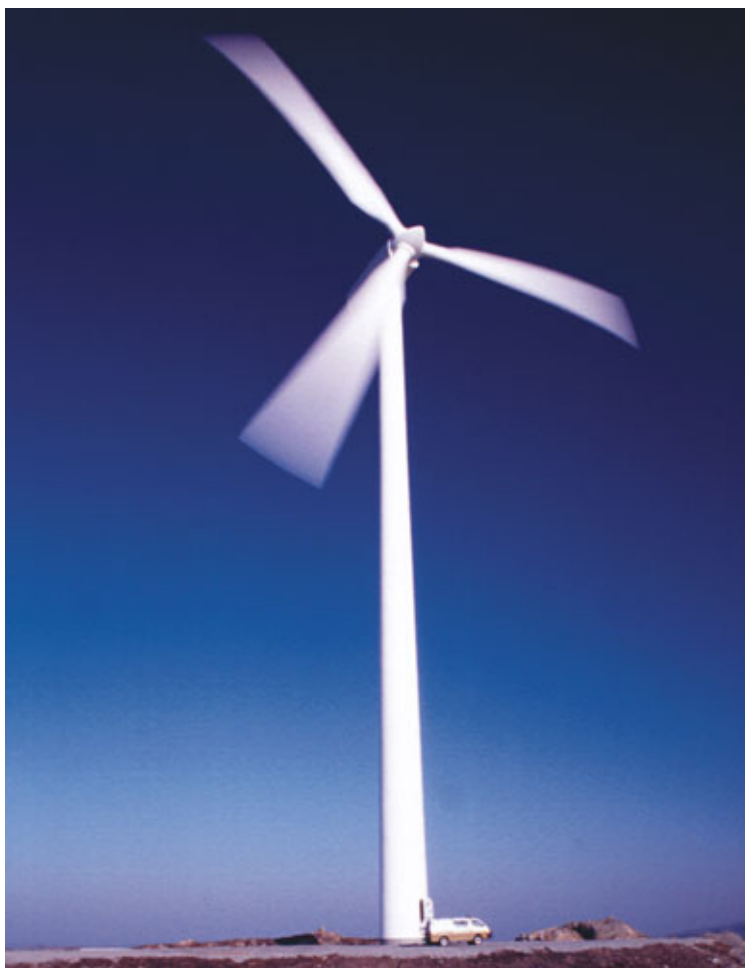
1,65 MW Vestas vindturbin på Hundhammerfjellet. Fotograf Steinar Johansen
