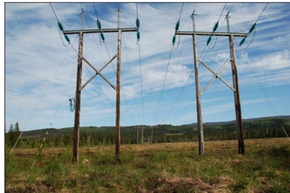
Parallele 66kV-ledninger
