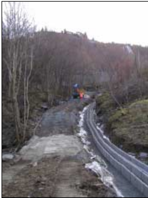
Figur 2: Ved legging av kabelanlegg i områder fri for tekniske inngrep, vil man få en anleggsveg ved siden av kabelgrøften. Bildet viser kabelgrøft for en 132 kV kabel med to kabelsett. (Foto: BKK)
