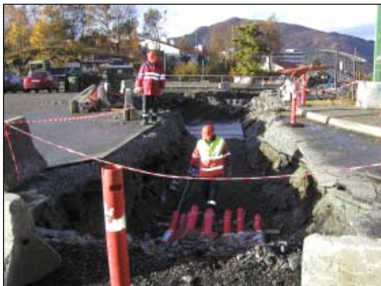
Figur 5.9: For kabelanlegg i tett befolkede områder med mye eksisterende infrastruktur vil entreprenørarbeidene være en stor del av totalkostnaden. (Foto: BKK)
