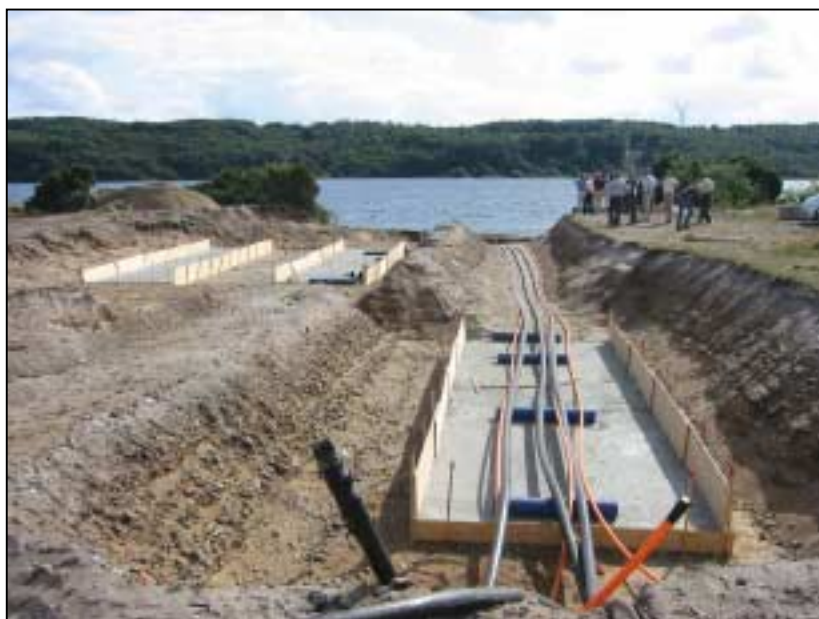
Figur 6: Bilde fra nettforbindelsen Katbjerg-Bramslev i Danmark. Bildet viser kabelgrøft for ett kabelsett med spenning 150 kV og to kabelsett med spenning 400 kV. Grøften har en total bredde på 20 m. (Foto: Tormod Eggan)
