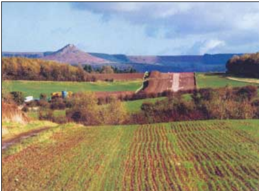
Figur 5: Kabeltrase ved Nunthorpe (Foto: Statnett)
