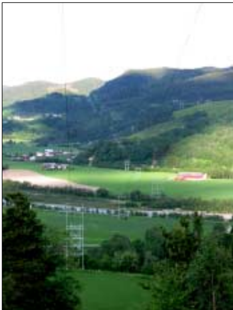
Figur 5.2: 132 kV luftledning (Foto: Tormod Eggan)
