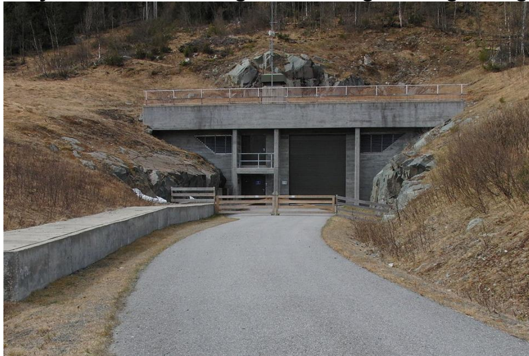
Frøystul, Reinvestering kontroll- og koblingsanlegg
