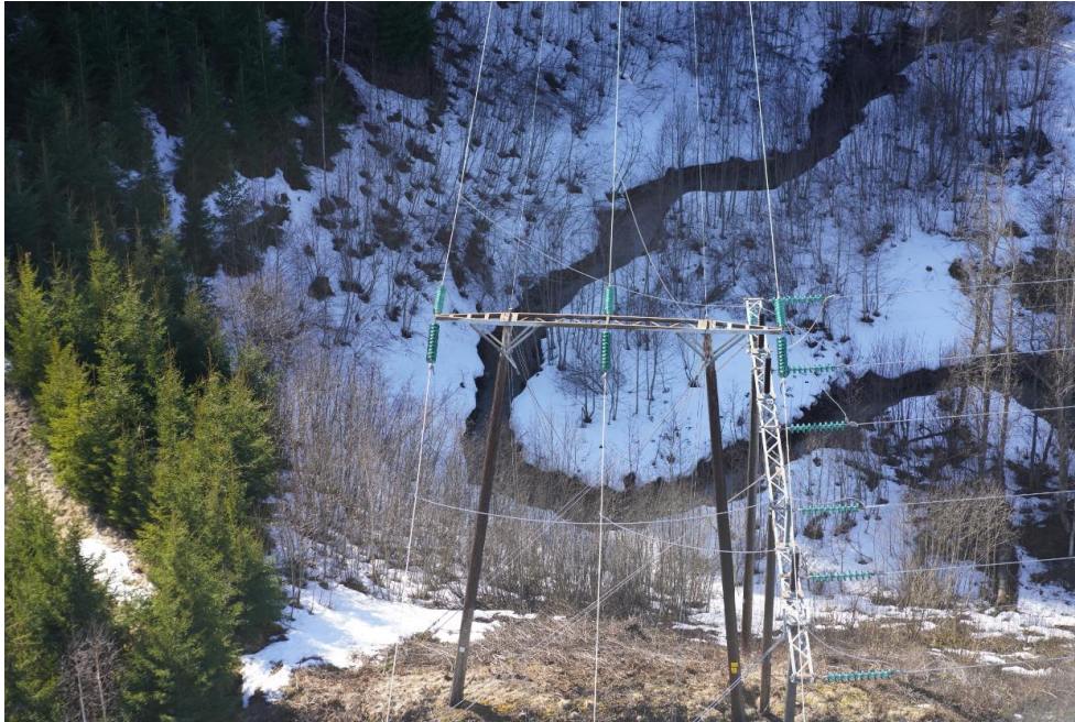
Skollenborg, nye endemaster 132kV
