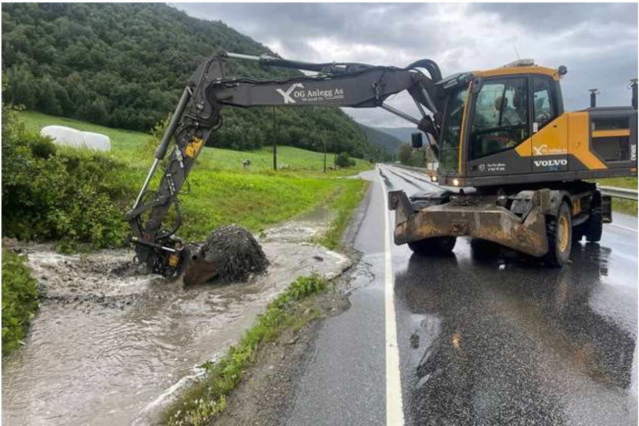
Rydding av stikkrenne i forbindelse med ekstremværet Hans på riksveg 15, Lom-Vågå. Foto: Asbjørn Stensrud
