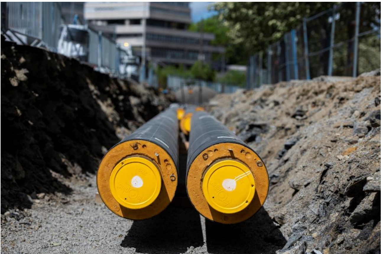
Fjernvarmerør til Lyse Neo i Paradis, Stavanger (Foto: Kristofer Ryde, juli 2019)
