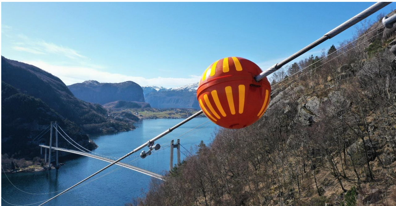
Drone har tatt bilde av flymarkør som er hengt opp på linje over Høgsfjord (Lnett, 2021)
