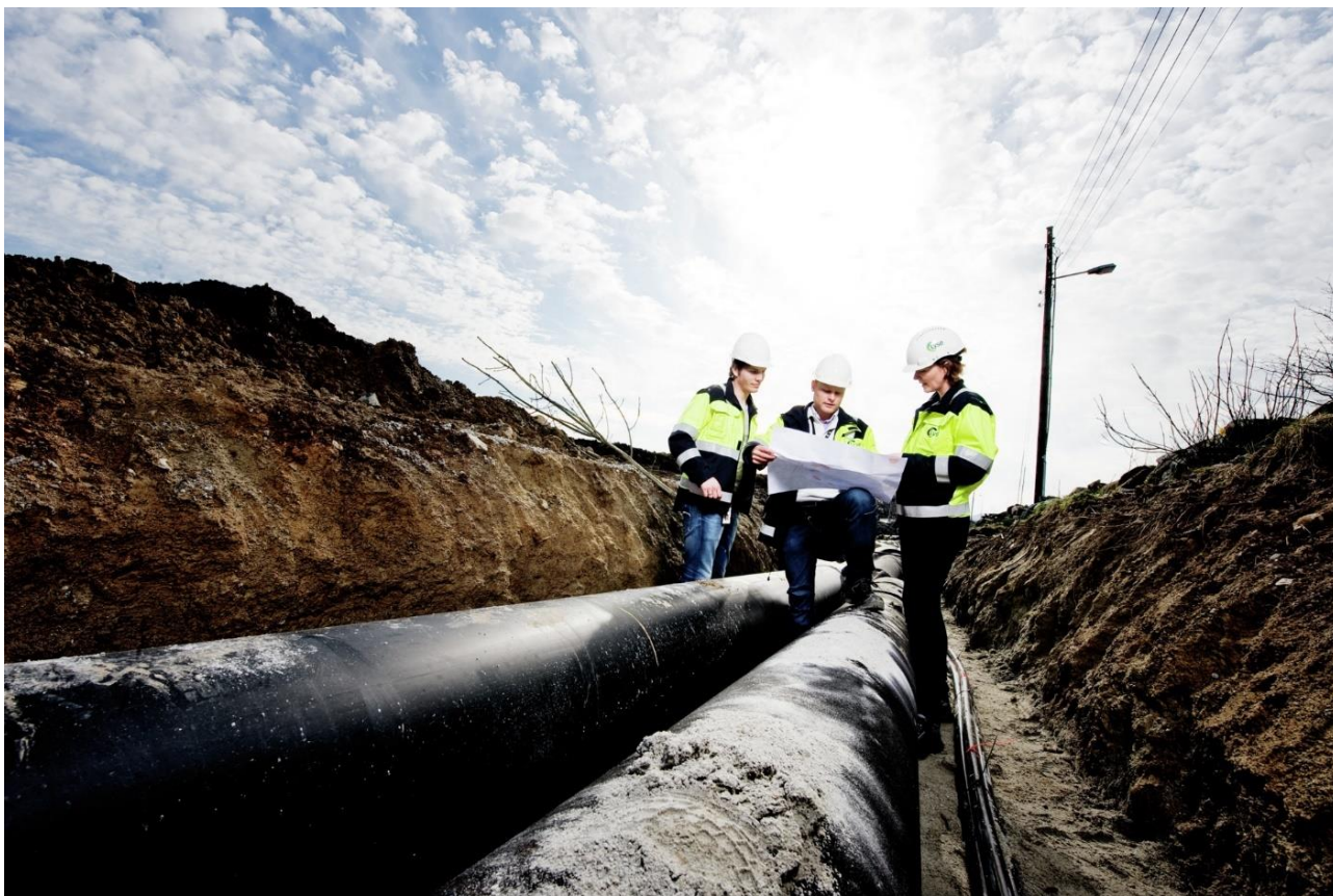
Fjernvarme rør legges fra Forus til Jåttåvågen (Foto: Fredrik Ringe)
