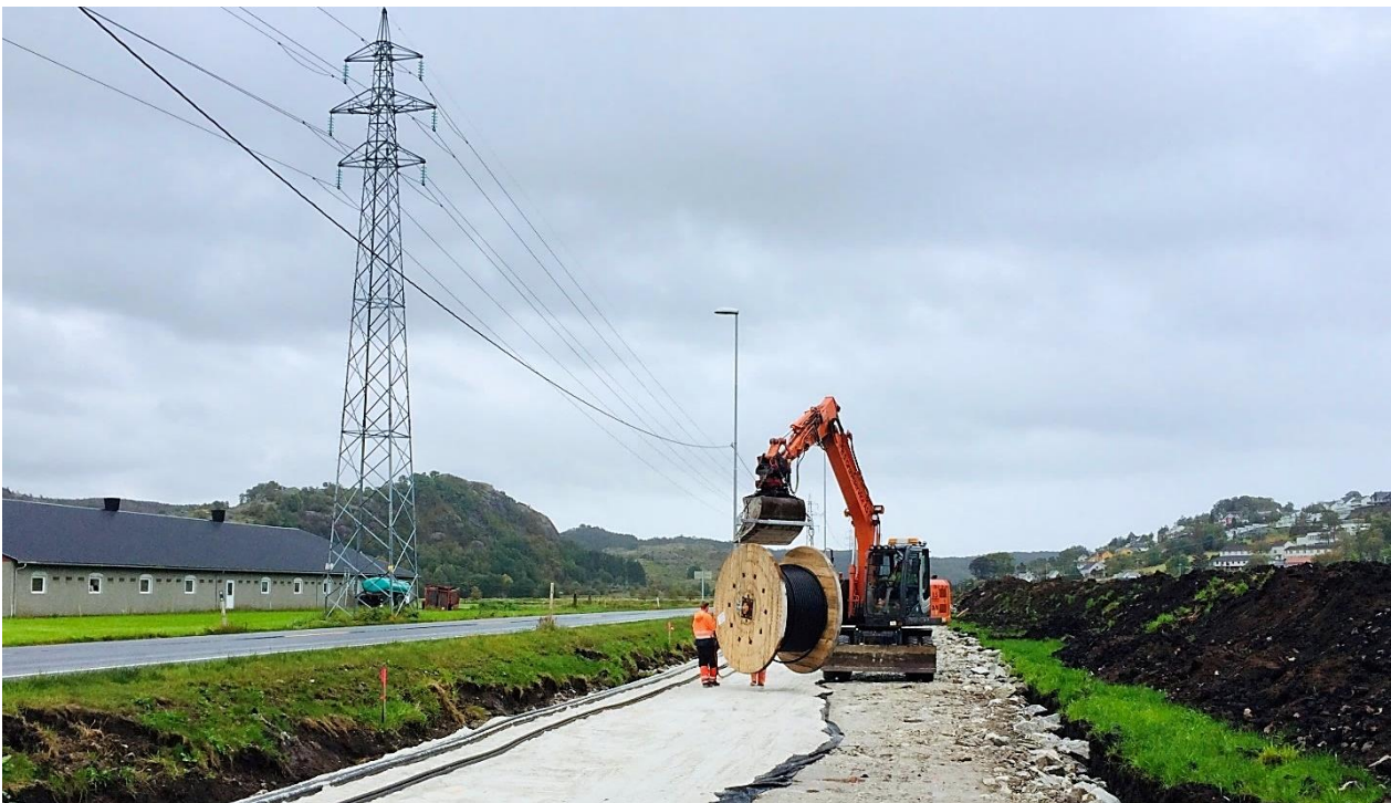
Legging av 22 kV-kabler på Slettebø i Eigersund kommune (Foto: Aleksander Klungland, september 2014)
