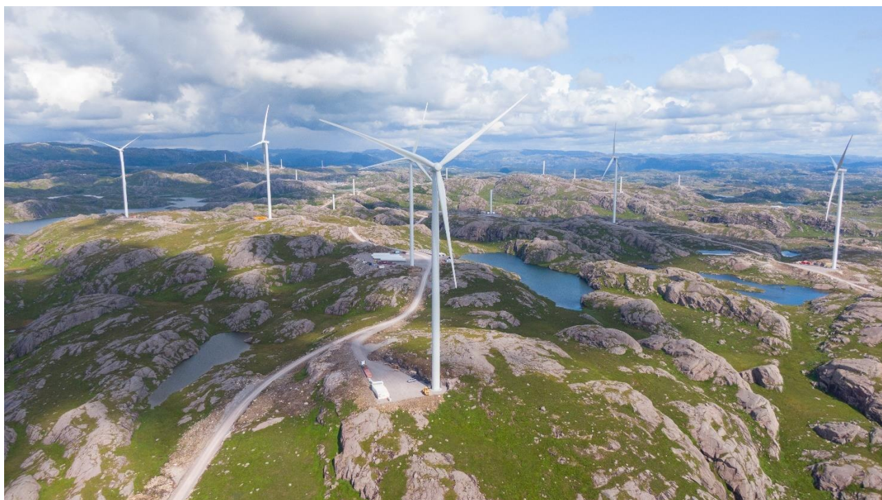
Bjerkreim vindpark – Søndre Klynge (Foto: Norsk Vind)
