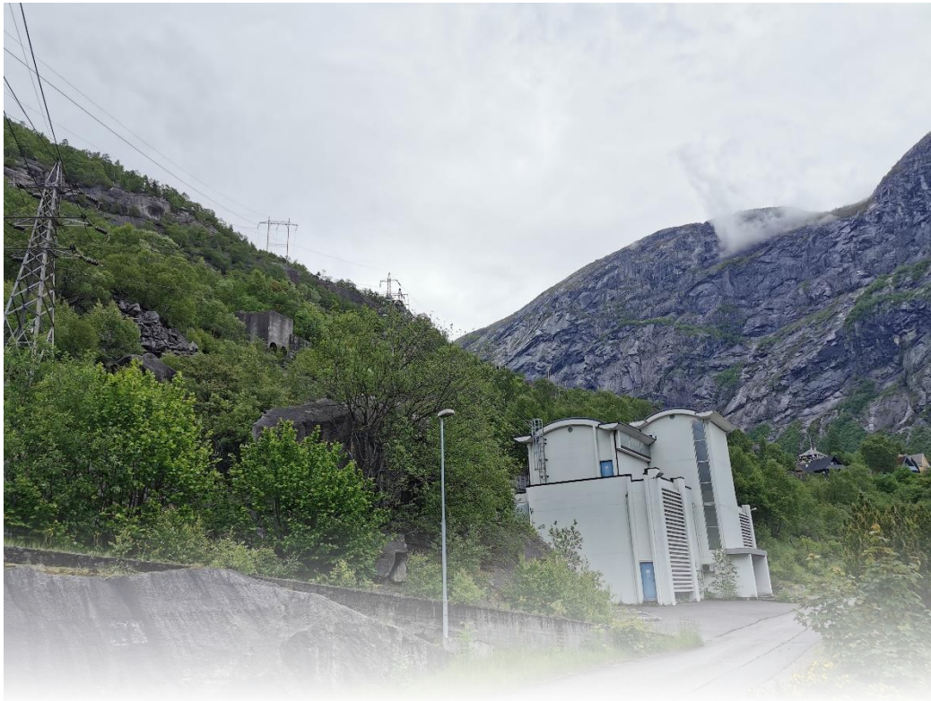
Stanavegen transformatorstasjon i Tyssedal
