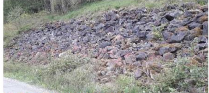
Figur 71. Støttemur/plastring langs Aunåsveien nær Bjørga.
