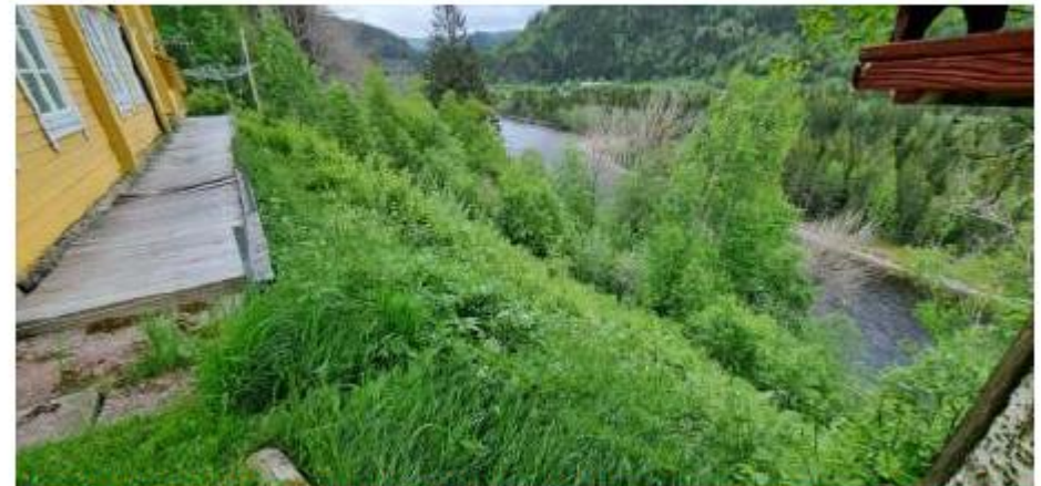
Figur 72. Omtrent 10 år siden jordskred i skråningen på nedsiden av plattingen. Setningsskader kan sees i plattingen til hovedhuset.
