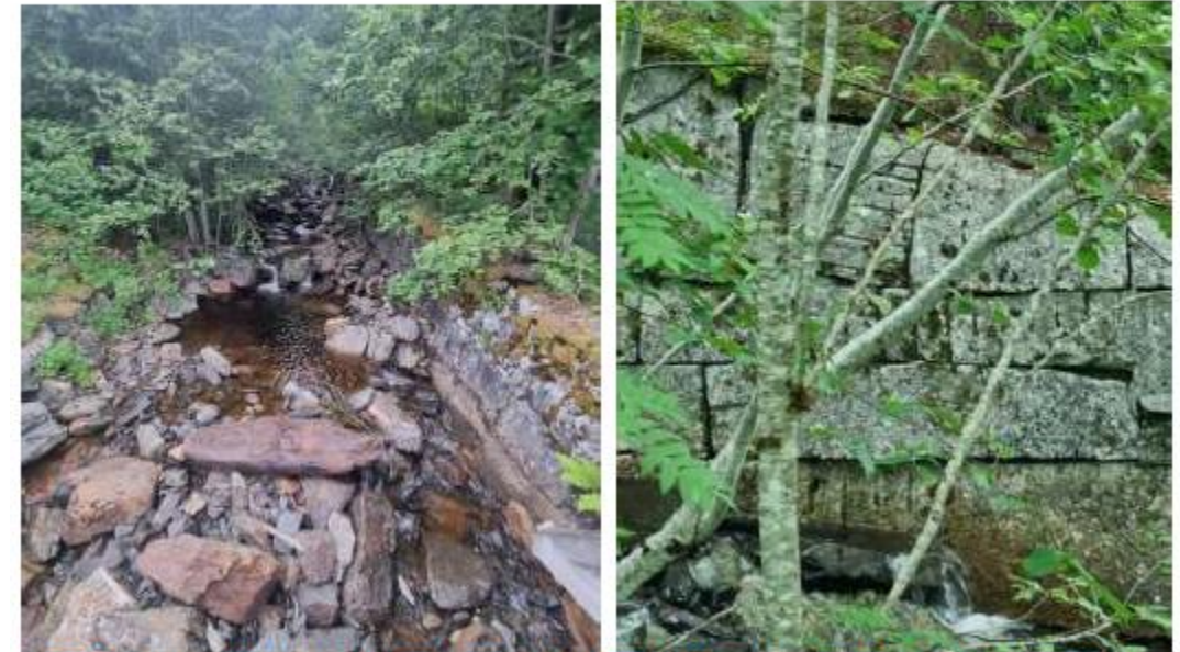
Figur 25. Stablete natursteinsblokker på hver side av løpet til Tøftbekken. I nedre del ved bru (venstre) og lenger oppstrøms (høyre). Sikringstiltaket er mellom 1 -2 m høyt.
