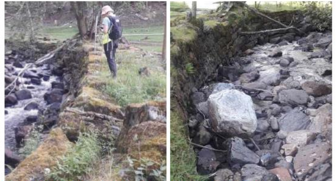
Figur 34. 1-2 m høy voll på yttersiden av bekken. Vollen er bygget opp av rektangulære blokker.
