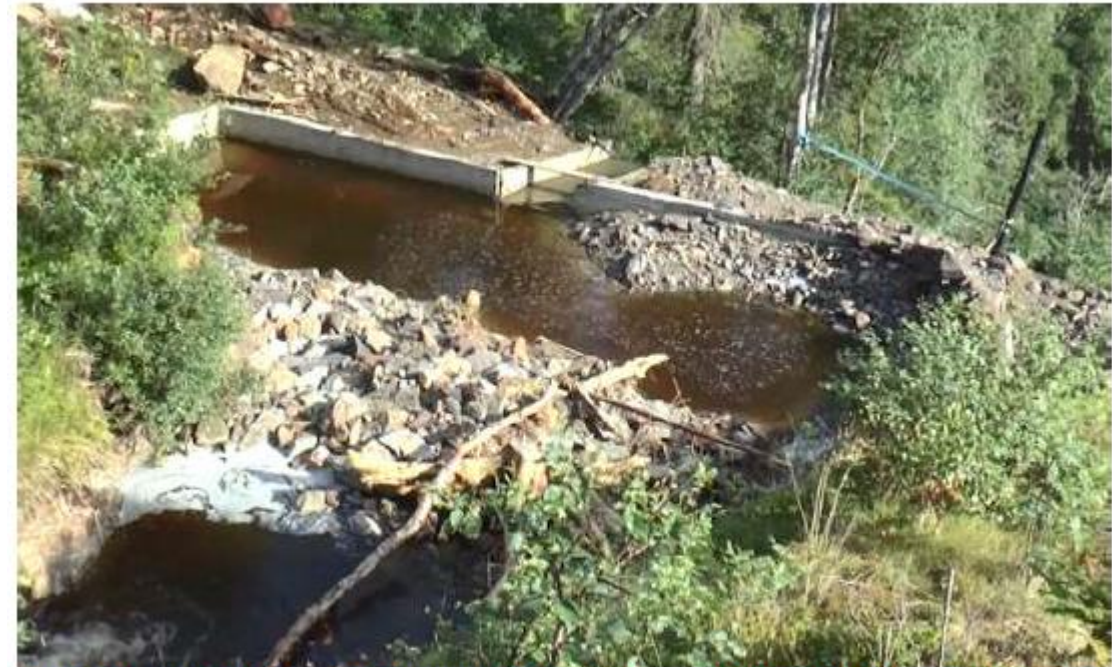
Figur 66. Oppdemning/lokalt kraftverk i Mølabekken fylt med sedimenter i 2018 hendelse. Bildet er skjermdump fra video fått av lokal beboer.
