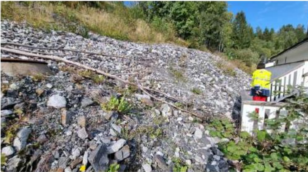
Figur 15. Motfylling og drenering i bolighus bak bolighus i spjelddalen.
