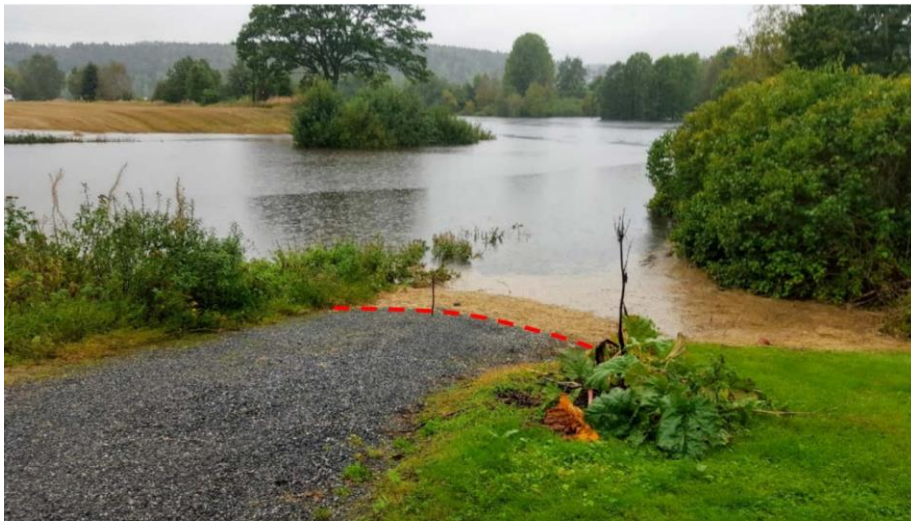
Figur 2: Avsetninger viser hvor vannet sto på sitt høyeste (markert med rød strek). Merk at vannstanden er lavere enn streken, som betyr at vannet er på veg ned.
