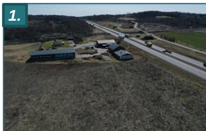
Varberg Norra 4.8 MW | 5.3 GWh
