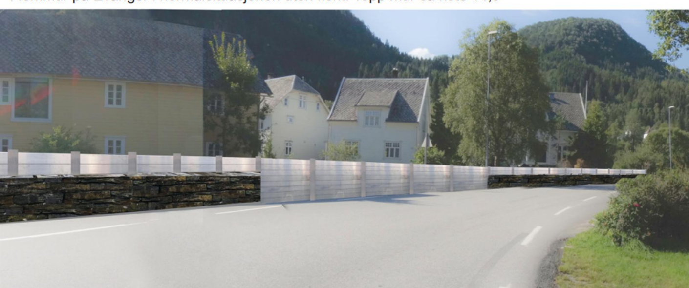
Flommur på Evanger påmontert mobile bjelkestengsel opp til kote 15,2
