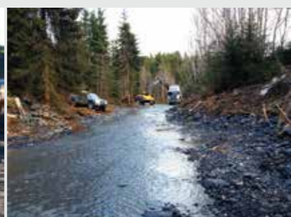
Heving av Sumpbekken.
