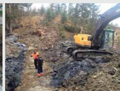
Bygging av tetterribbe for å hindre vannet å forsvinne i fyllingen.
