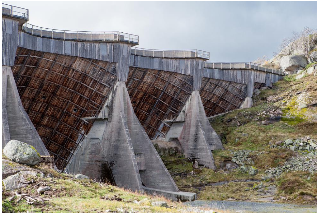
Fig. 5 Nåvatn III, den minste av de to flerbuedammene. Foto: Stig Storheil/NVE. 2016.
