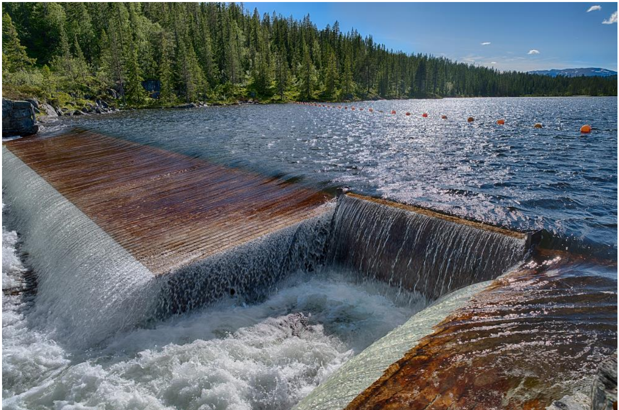
Fig 3 Gausbuvatn dam i Tokke, Telemark. Tømmerkistedammen ble rehabilitert i 2006. Foto: Stig Storheil/NVE, 2017.
