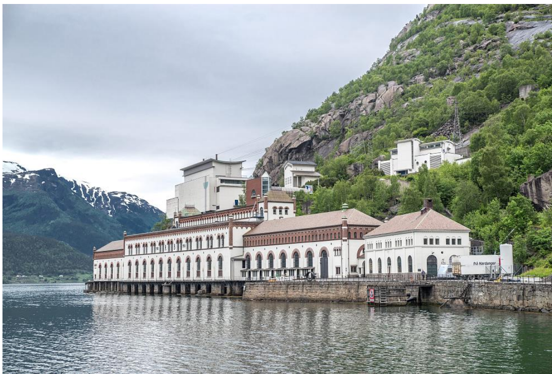
Fig. 1 Fredete Tyssø I kraftstasjon i Tyssedal. Foto: Stig Storheil/NVE.
