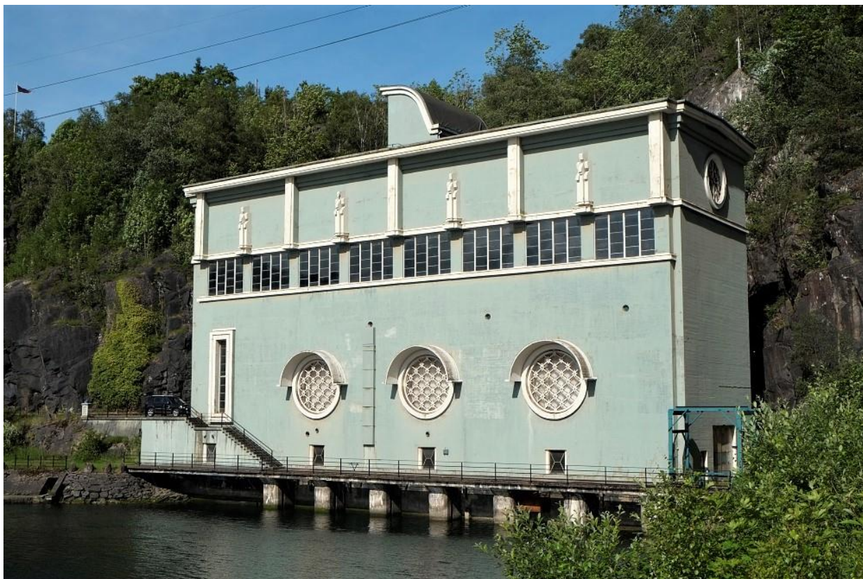
Fig. 2 Suda III fra 1930. Suda III er et av flere anlegg foreslått fredet i Statkrafts landsverneplan. Foto: Unn Yilmaz/NVE, 2014.
