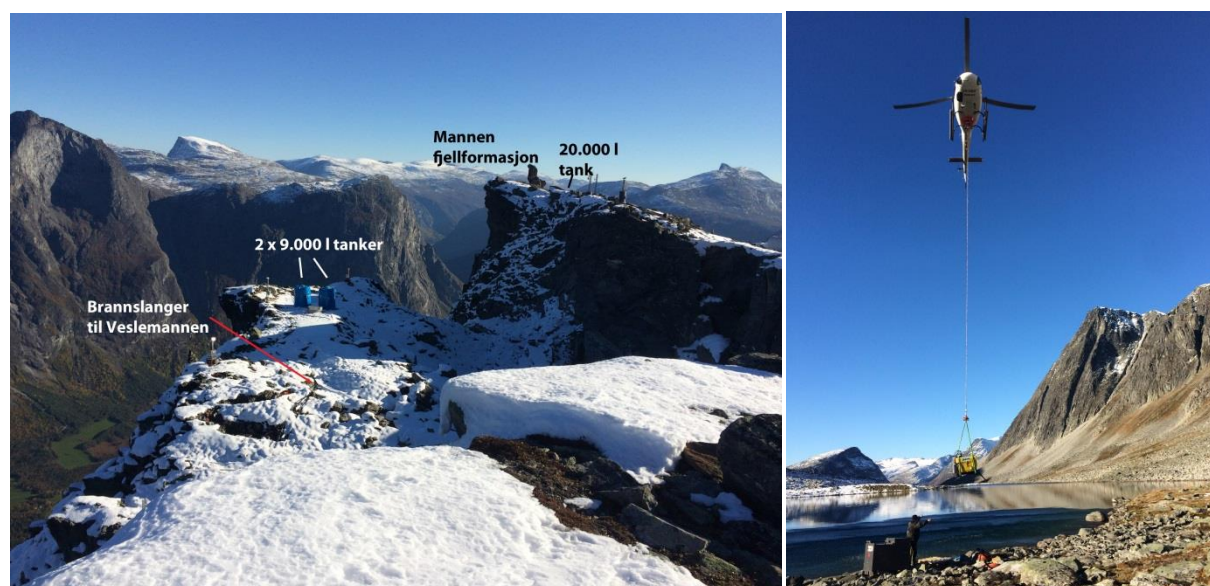
Figur 3 Venstre: Bilde som viser Mannen og tankene. Høyre: Nedsetting av pumpe med helikopter.
