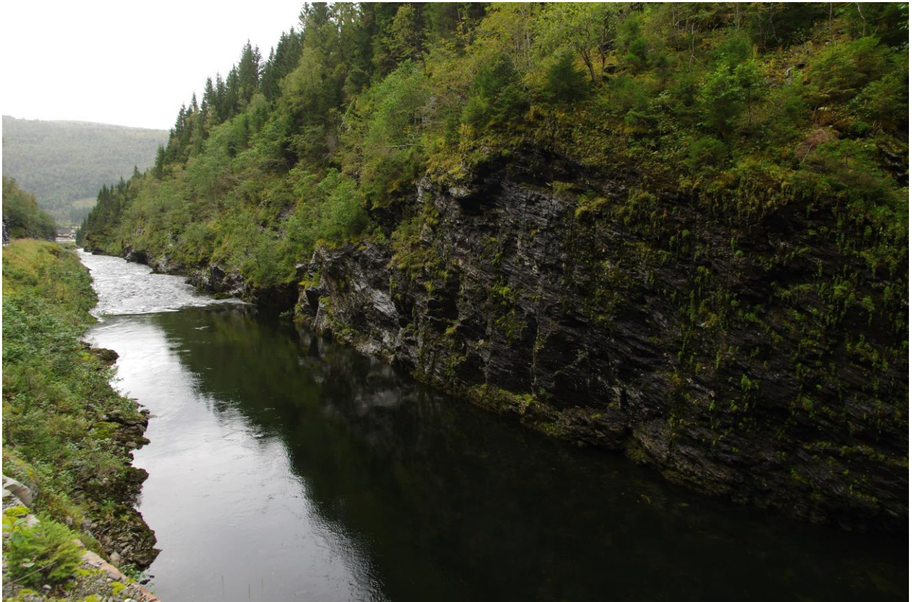
Figur 3 Kanalisering med terskel i utløpet av Myrkdalsvatn
