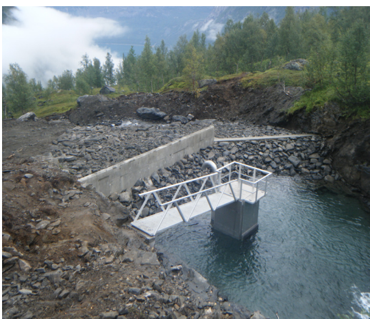
Bilde 3. Skarelva kraftverk, Narvik, Nordland. Foto: NVE.
