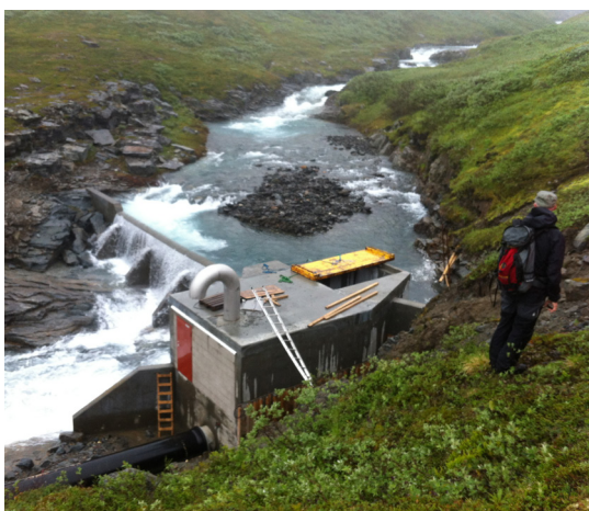
Bilde 4. Dittielva kraftverk, Bardu, Troms. Foto: NVE
