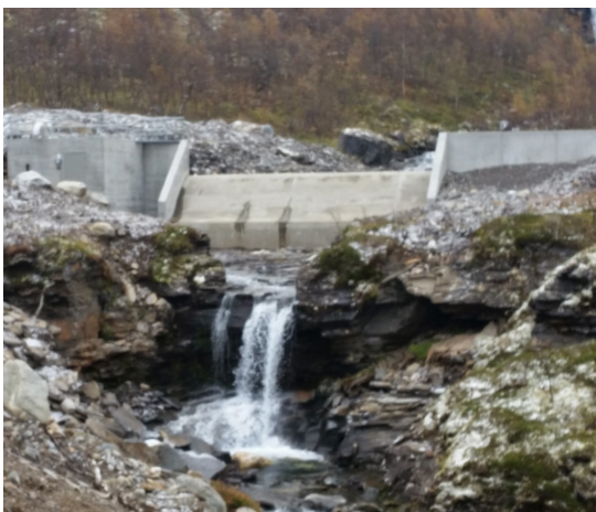
Bilde 1. Bergselva kraftverk i Storfjord, Troms. Foto NVE.
