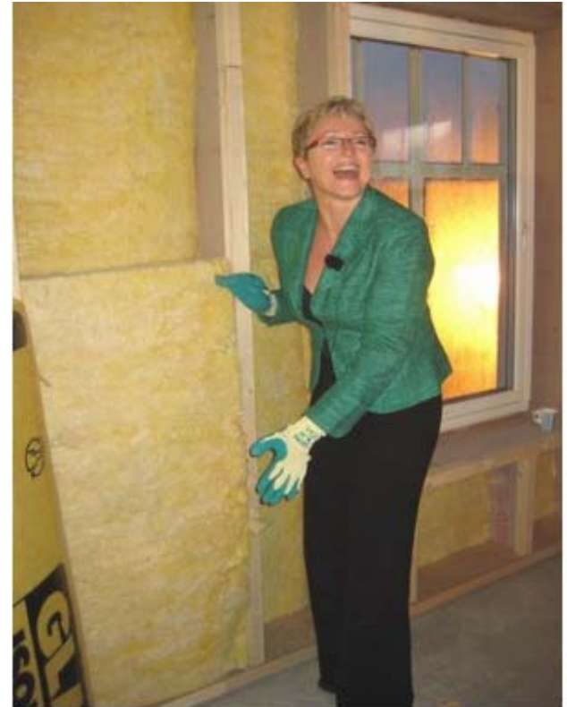
Navarsete tar selv i et tak for å isolere passivhuset
