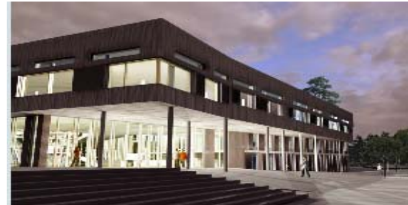
Nesodden kommunesenter. Kontordelen passivhusstandard, kulturdelen svært nær passivhusstandard. Hele kommunesenteret får A-merke. Ferdigstilles 2011. Bygges av Skanska. Kilde: Hjeltnes Consult
