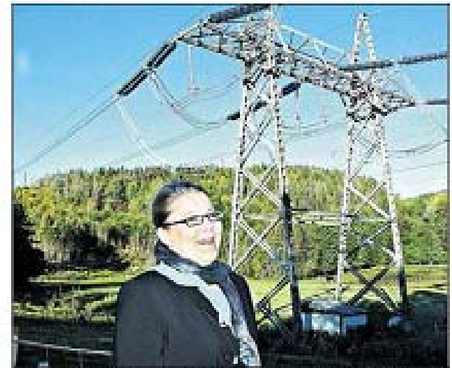
Den gamle mastetypen kan gjerne byttes ut, mener Eva Widenoja - her fotografert i Vestmarka. Bærum ved den doble 500 kV-linjen som går mellom Sykkle og Hamar. © 2014/2015 Widenoja AS
