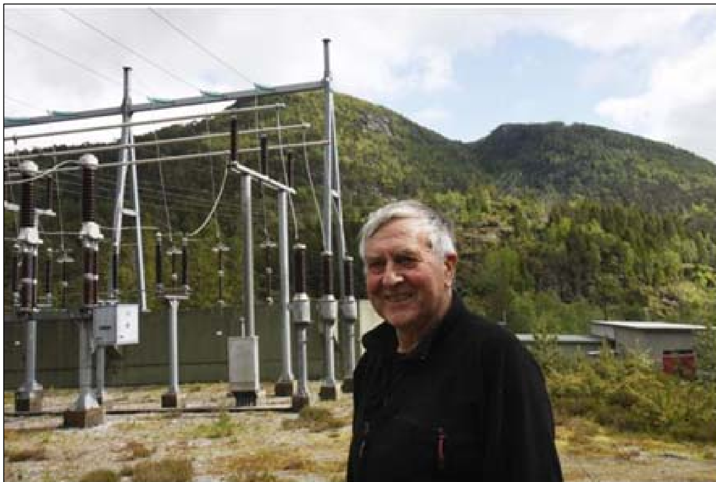
KRAFTLINJE, JA TAKK: Pensjonist Kolbjørn Løken (76) har passet transformatorstasjonen på Grov i Flora kommune 161 år. Han mener kraftlinjer vil hjelpe fylket til å unngå fraflytting. Foto: Knut Magnussen, Firda
