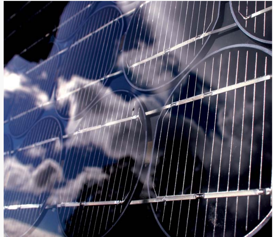
Del av solcelleveggen på elektrobygget, Gløshaugen
